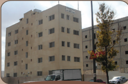
مبنى مؤسسات المجتمع المدني - مخيم الوحدات
